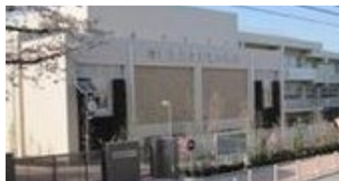
松溪中学校 (区ホームページより)
